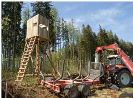
**Aufstellen einer vorgefertigten Kanzel mittels Krananhänger.**
